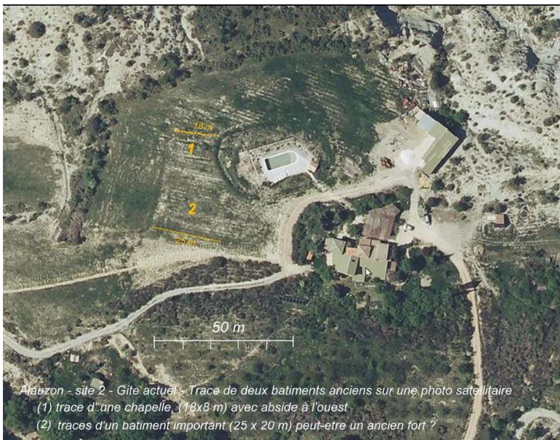
Fig.2 - Photosatellite (source Googlemap) du site A2 d'Alauzon au quartier "Lauzon", montrant les traces de constructions anciennes, probablement d'âge médiéval.
